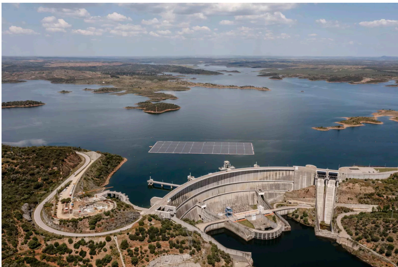
Figura 8.29 – Central solar flutuante da EDP em Alqueva - EDP
