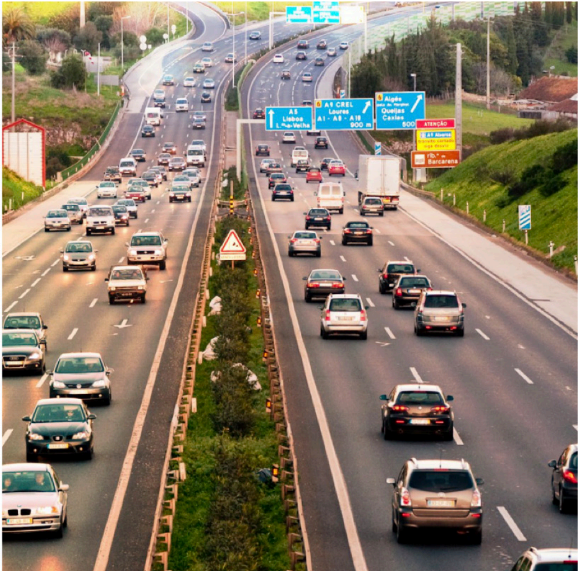
Figura 8.30 – Autoestradas - Brisa - Autoestradas de Portugal
